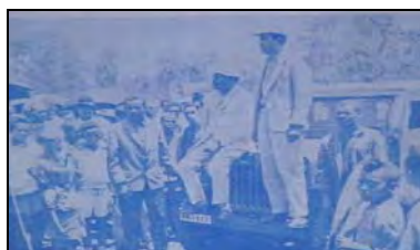
ህዝብ በሚሰበሰብባቸው ሥፍራዎች በባለሙያዎች ለህብረተሰቡ የጤና ትምህርት ሲሰጥ
